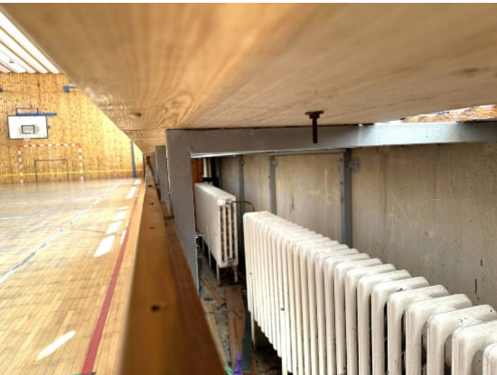
Pohled dovnitř zákrytu otopných těles tělocvičny
