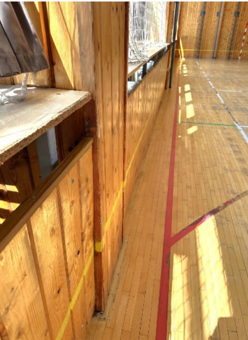
Pohled boční na zákryt otopných těles
